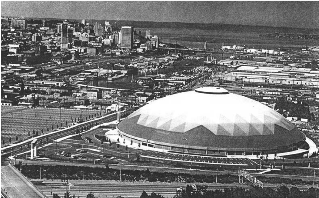
Рис.2.Купольное покрытие стадиона в г. Такома (США) диаметром 162 м
